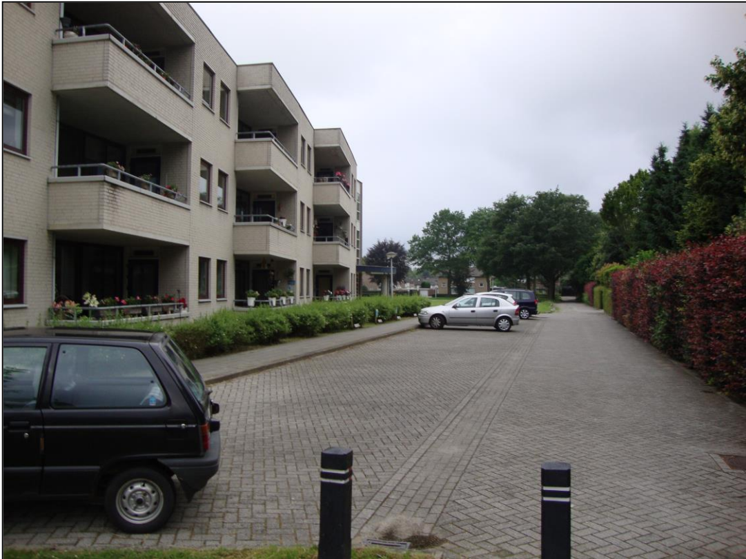
Het ten zuiden van deelgebied 1 gelegen bouwdeel van Zorgcentrum Vivre. Achter de haag (op de foto rechts) bevindt zich het plangebied
